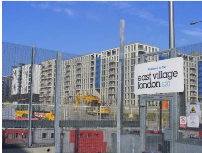
Fig. 16: travaux de construction à East Village London, ancien village olympique comptant aujourd'hui 2 818 logements dont 1 379 logements abordables.
