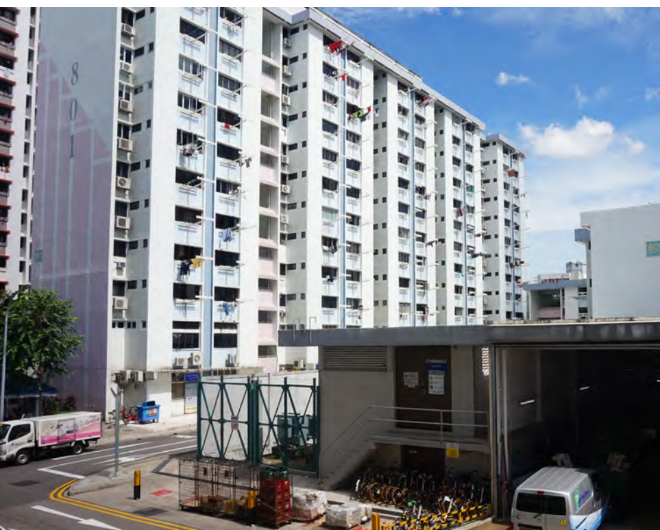
Fig. 17 Des immeubles de logement public à Jalan Besar.
