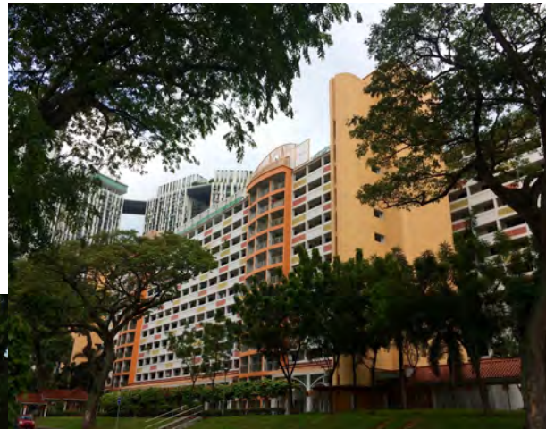
Fig. 22 Des immeubles de logement public à Outram.
