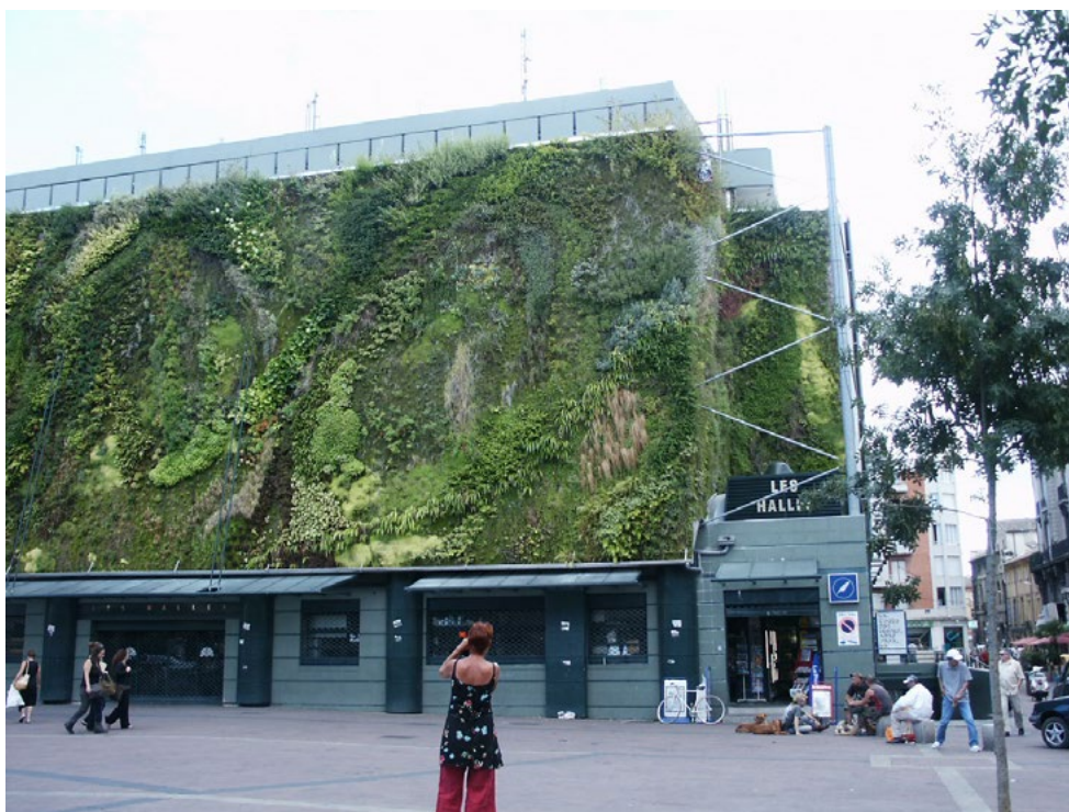
Fig. 22 Façade végétalisée des Halles, Place Pie à Avignon.
