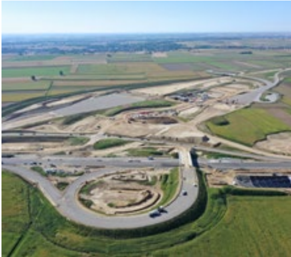
Chantier du Coutournement ouest de Strasbourg.
