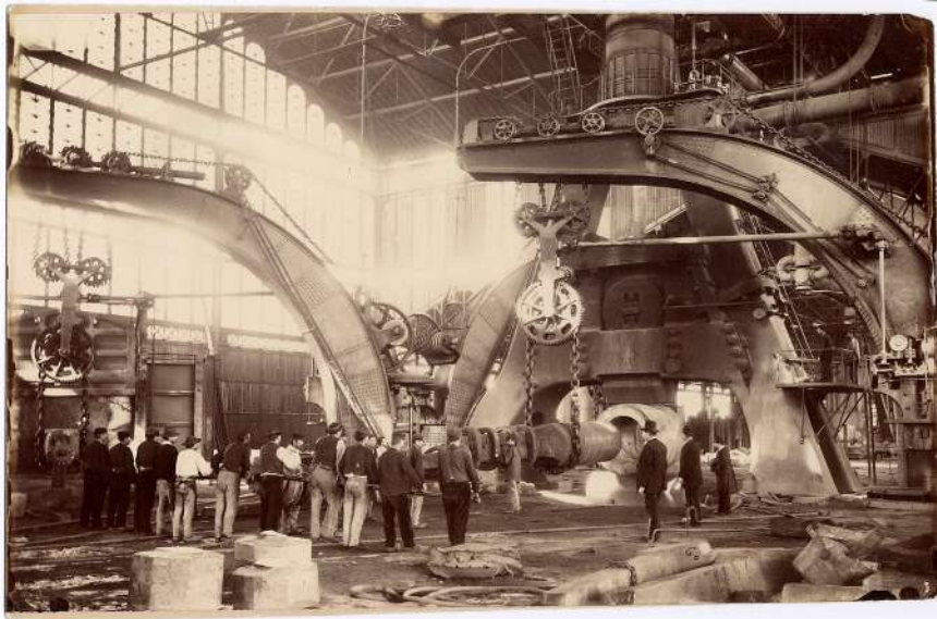
Figure 7 : Halle au marteau-pilon de 100 tonnes / Charles Lallement, extrait de l'album des établissements Schneider de 1881.
