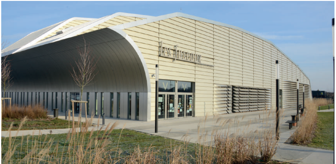
Les Fuseaux — salle de spectacle à Saint-Dizier
