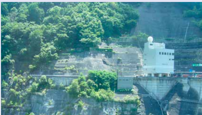
Bétonisation d'un pan de montagne dans les Alpes japonaises, aux abords d'un barrage hydroélectrique.
