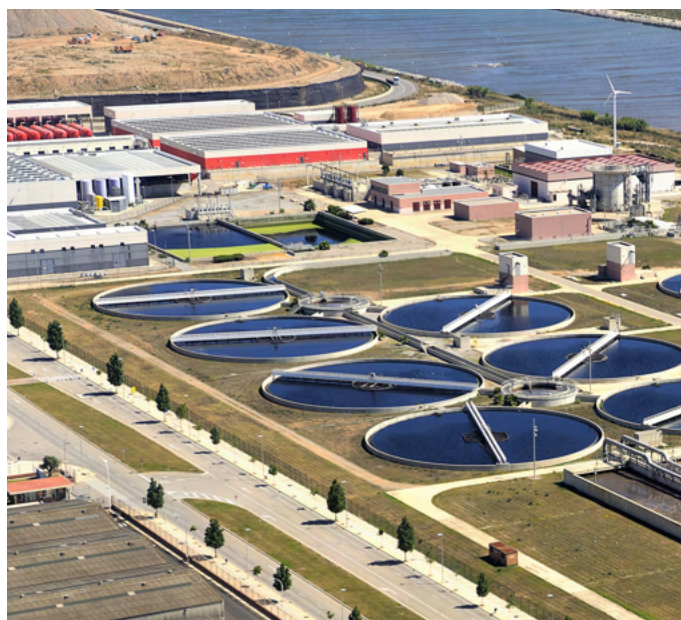
→ Usine de dessalement et régénération du Llobregat
